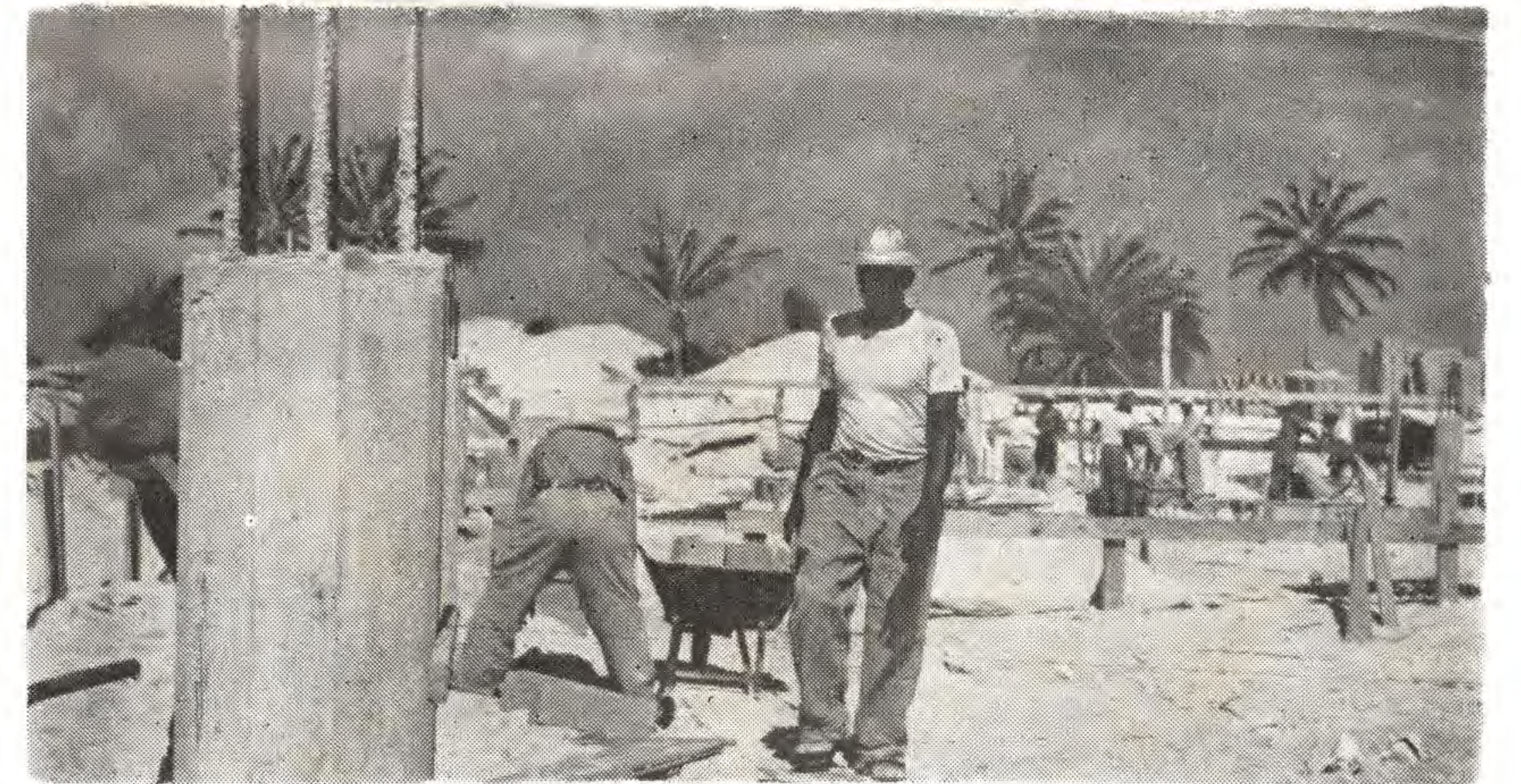
Het funderingswerk van dichtbij. E trabou di e fundeshi mirá di acerca. A close-up of the foundation-work.
